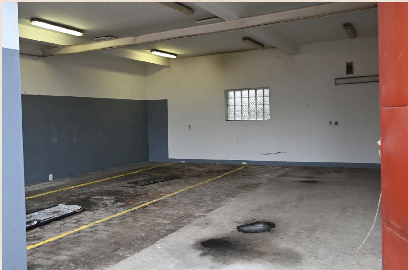
Původní stav hasičské zbrojnice před rekonstrukcí - garáž
